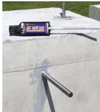
کاشت پیچ به کمک مواد اپوکسی داخل کپسول
