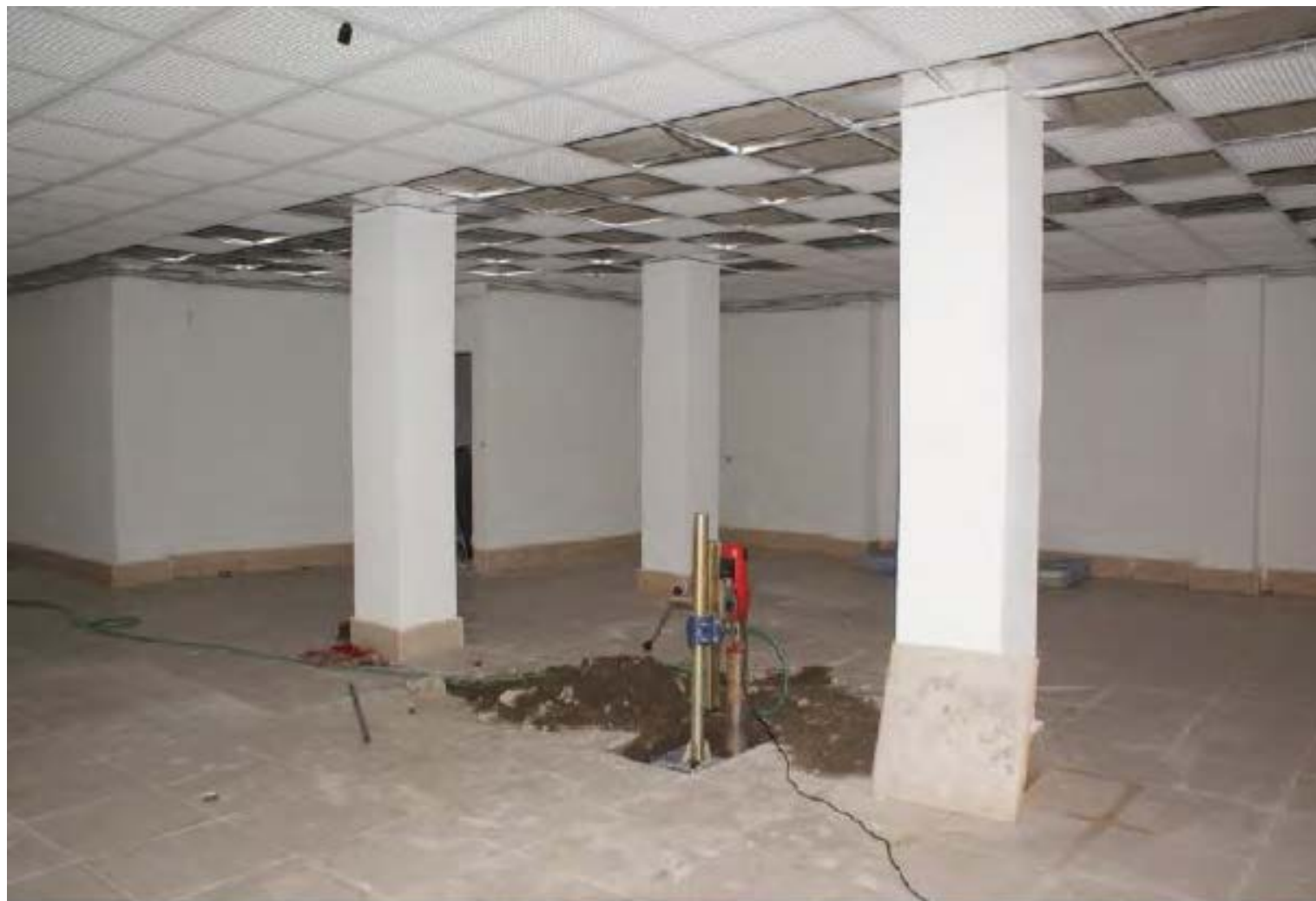
مغزه گیری بتن از تیر اصلی طبقه اول (داخل مغازه)
