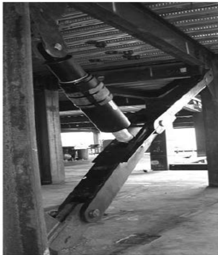
اشکال ترکیبی از نصب میراگر در ساختمان‌های بلند
