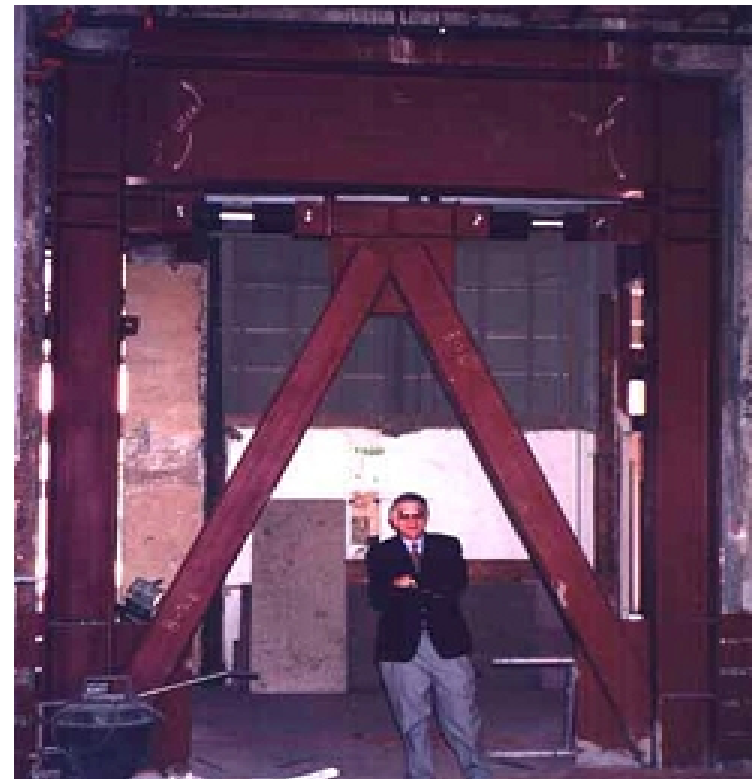
استفاده از میراگرهای ویسکوز در بادبندهای جناقی
