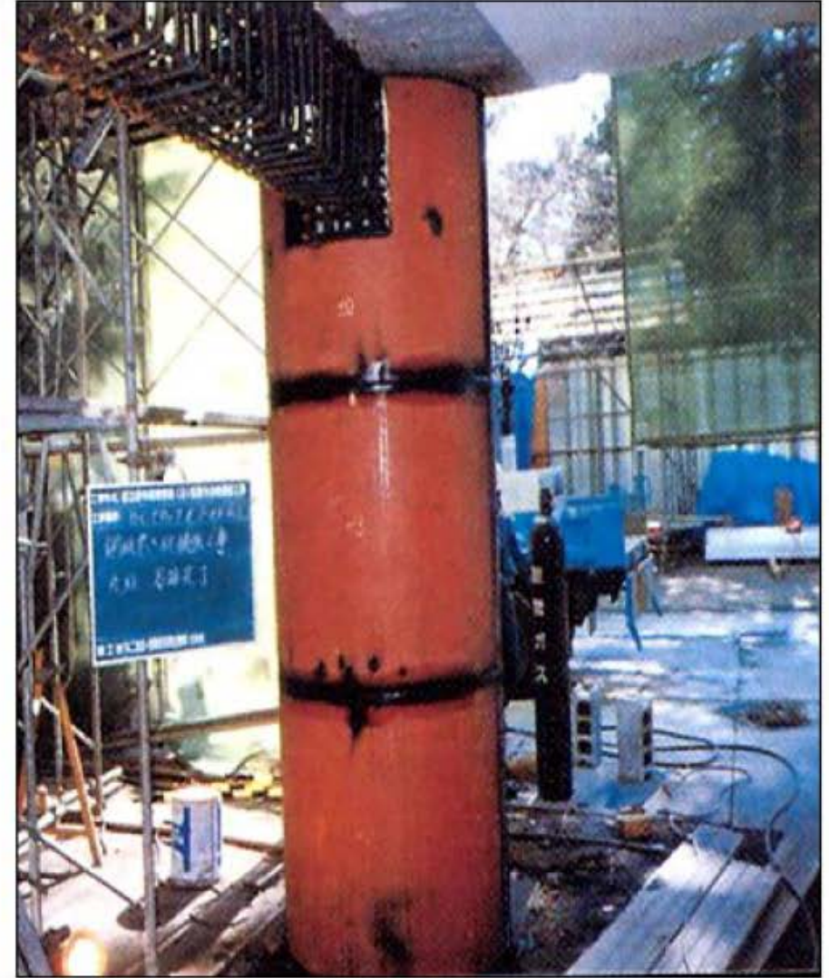
استفاده از روکش فولادی مدور در بهسازی ستون‌های مستطیلی
