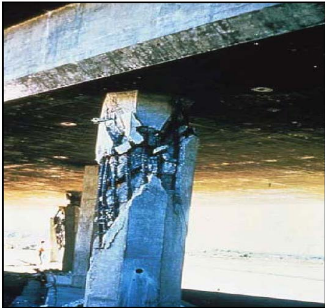
نمونه‌ای از شکست برشی ستون
