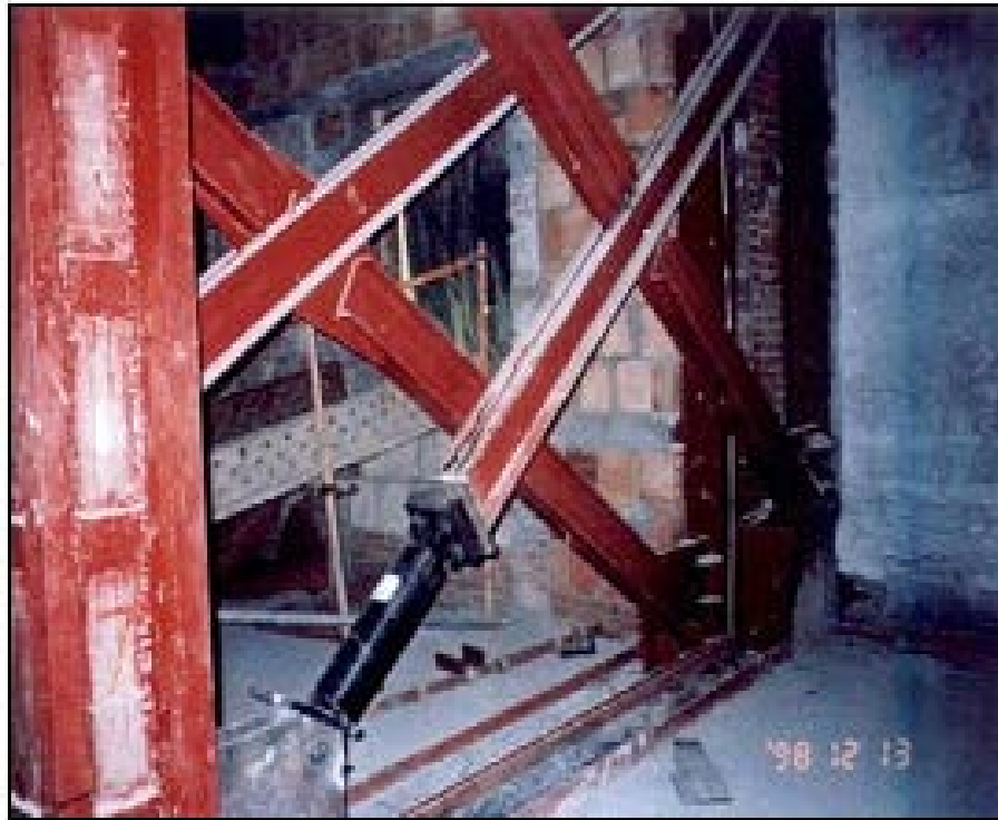
استفاده از میراگرهای ویسکوز در بادبندهای قطری
