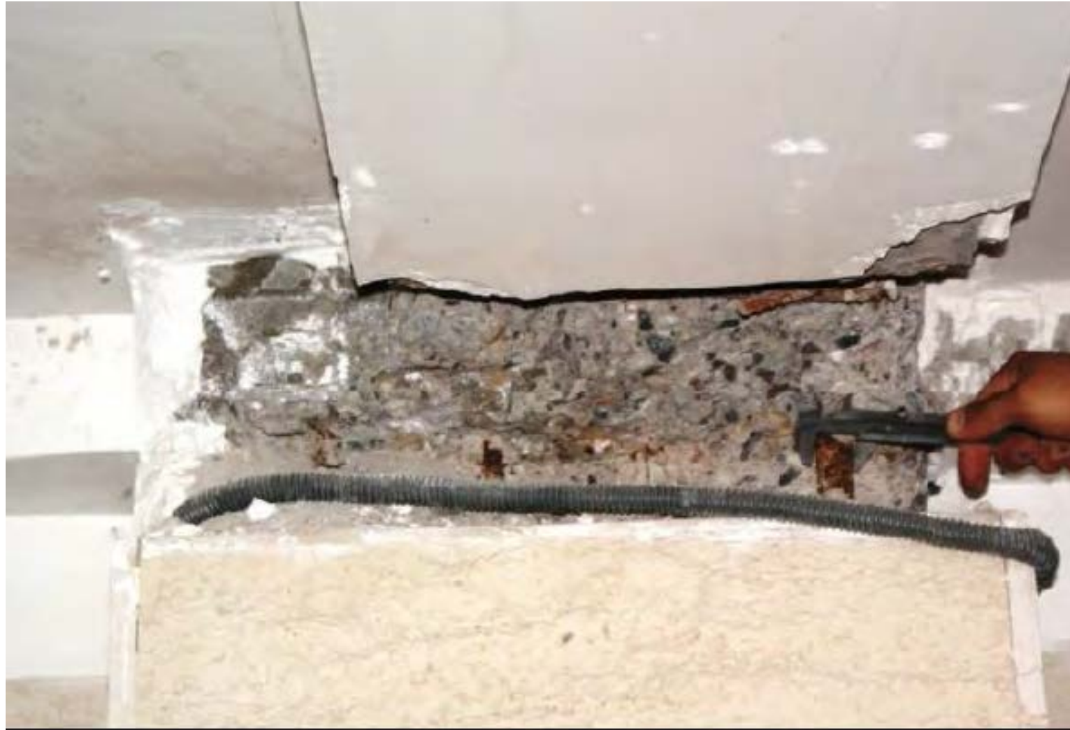
ردیابی چهار آرماتور طولی شماره ۲۲ برای ستون در سونداز محور A5 همکف
