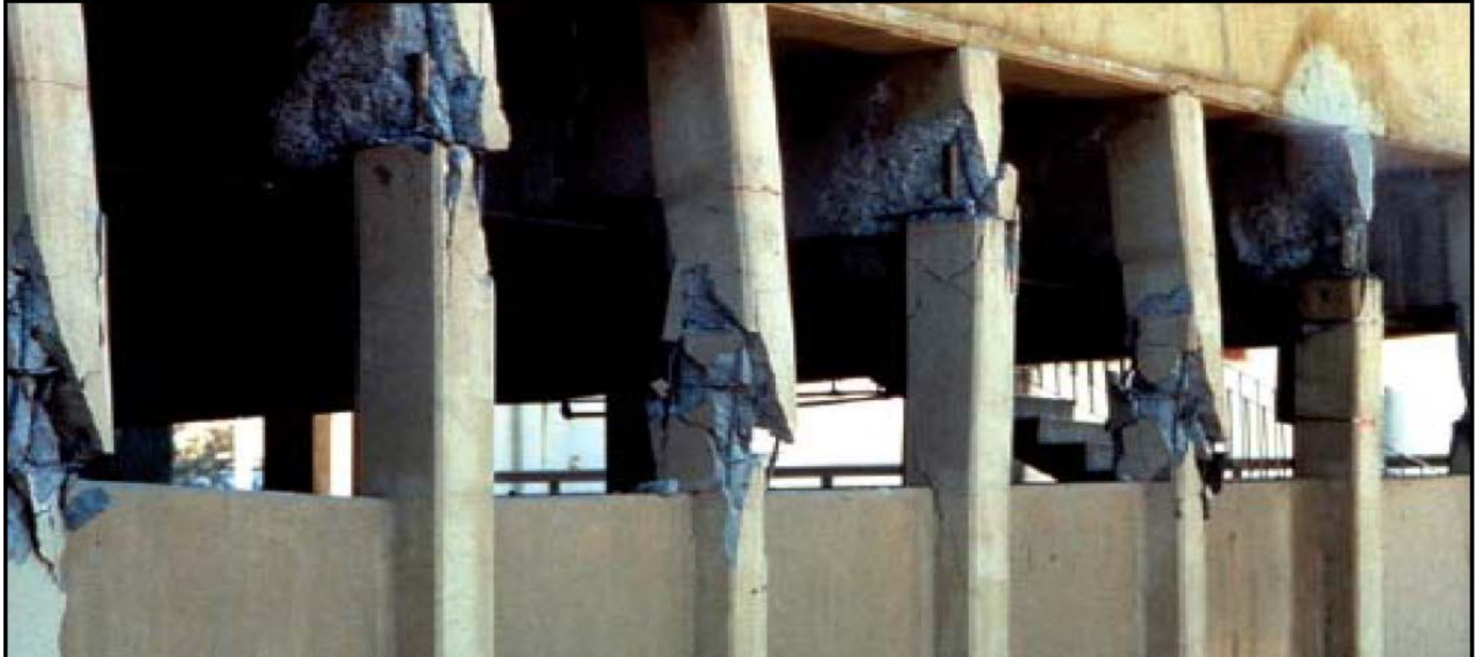
مکانیسم خرابی در عملکرد تیر قوی - ستون ضعیف و ستون کوتاه
