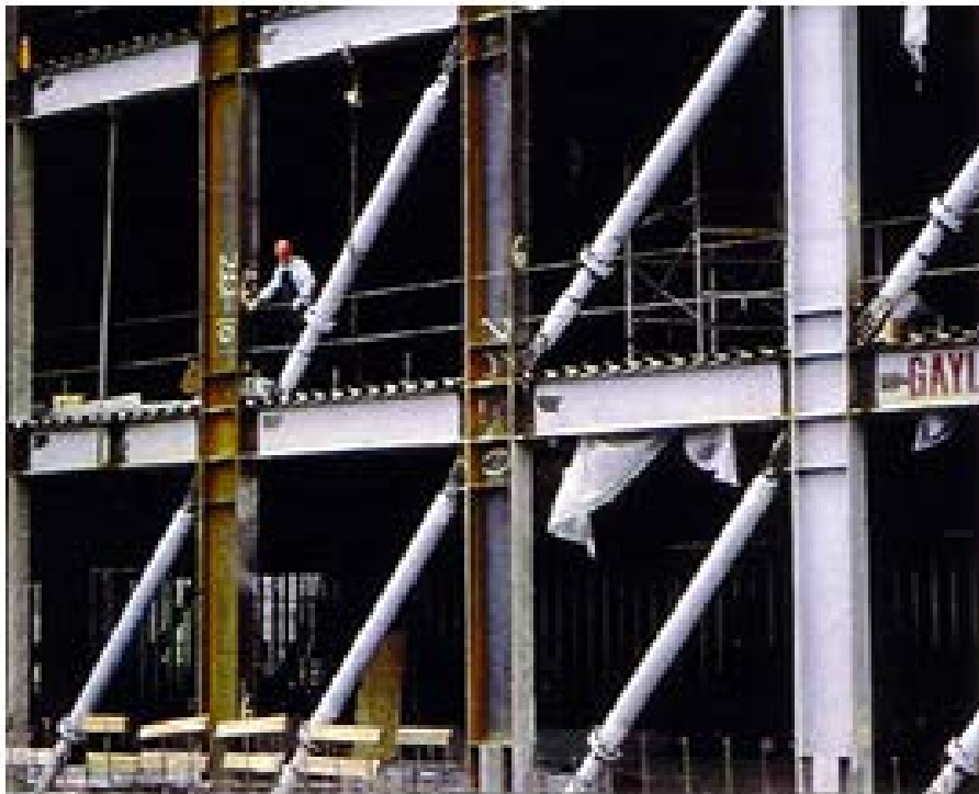
استفاده از میراگرهای ویسکوز در بادبندهای قطری
