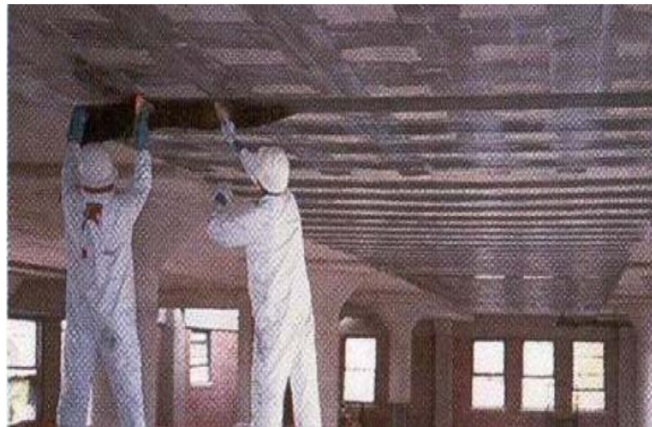
تقویت دال با نوارهای FRP در دو جهت
