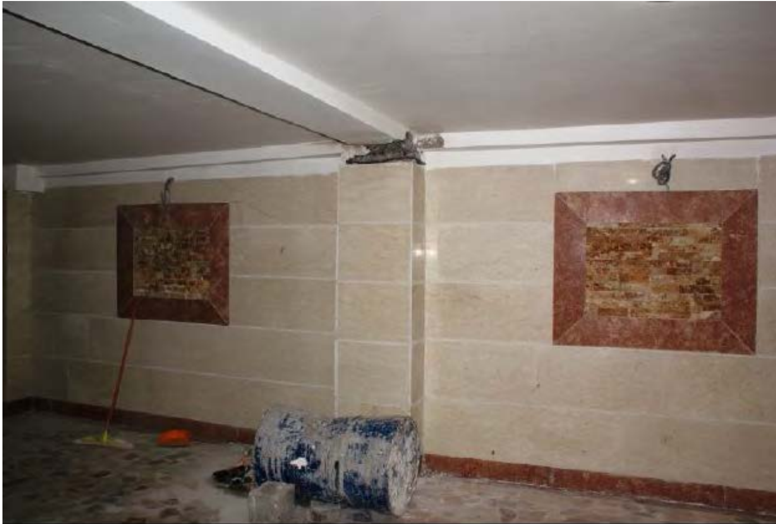
سونداژ اتصال تیر به ستون در محور A5 همکف
