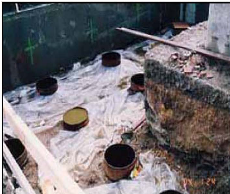
مراحلی از احداث شمع های جدید و اتصال آن به شالوده
