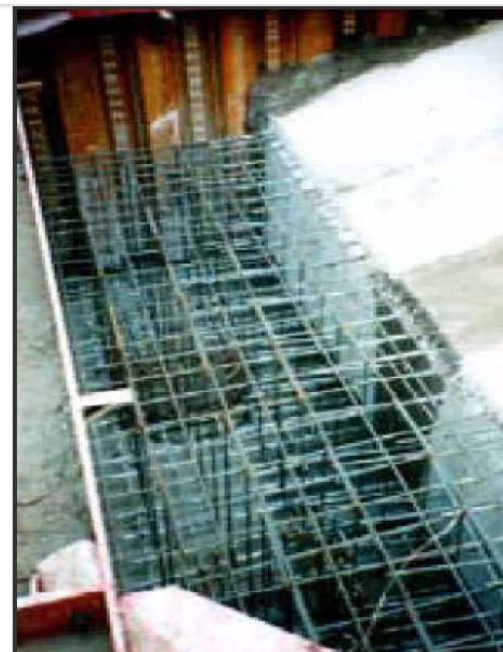
مراحلی از احداث شمع های جدید و اتصال آن به شالوده
