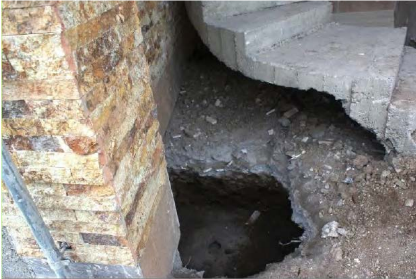
سونداز و مغزه گیری از بتن پی در محور D10
