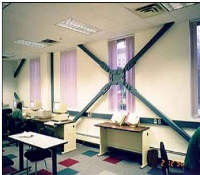
استفاده از میراگرهای اصطکاکی پال (Pall) در مقاوم سازی
